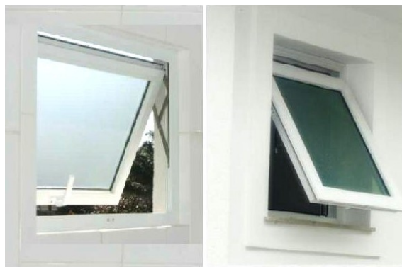
Detalhes interno e externo da janela "maxim-ar" com vidro miniboreal
